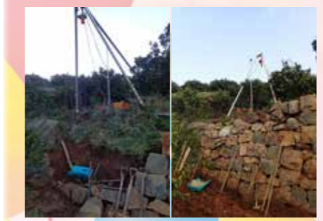
▲大雨で崩れた石垣を積み上げました。左が補修前で右が補修後の写真です
